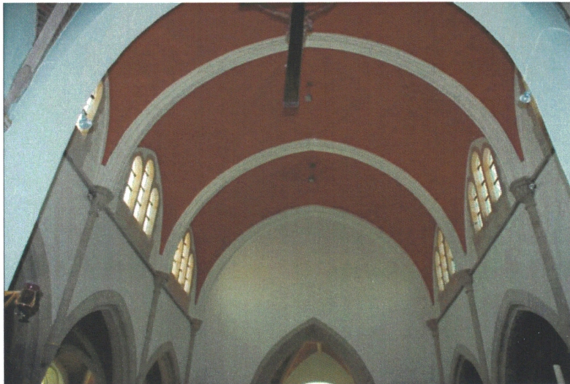
afb.26 Overwelling van de middenbeuk, angebracht bij herstel van de schade opgelopen tijdens WOII (foto auteur)
